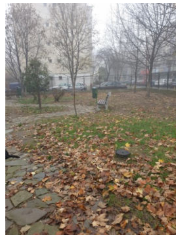
hidrant de exterior
