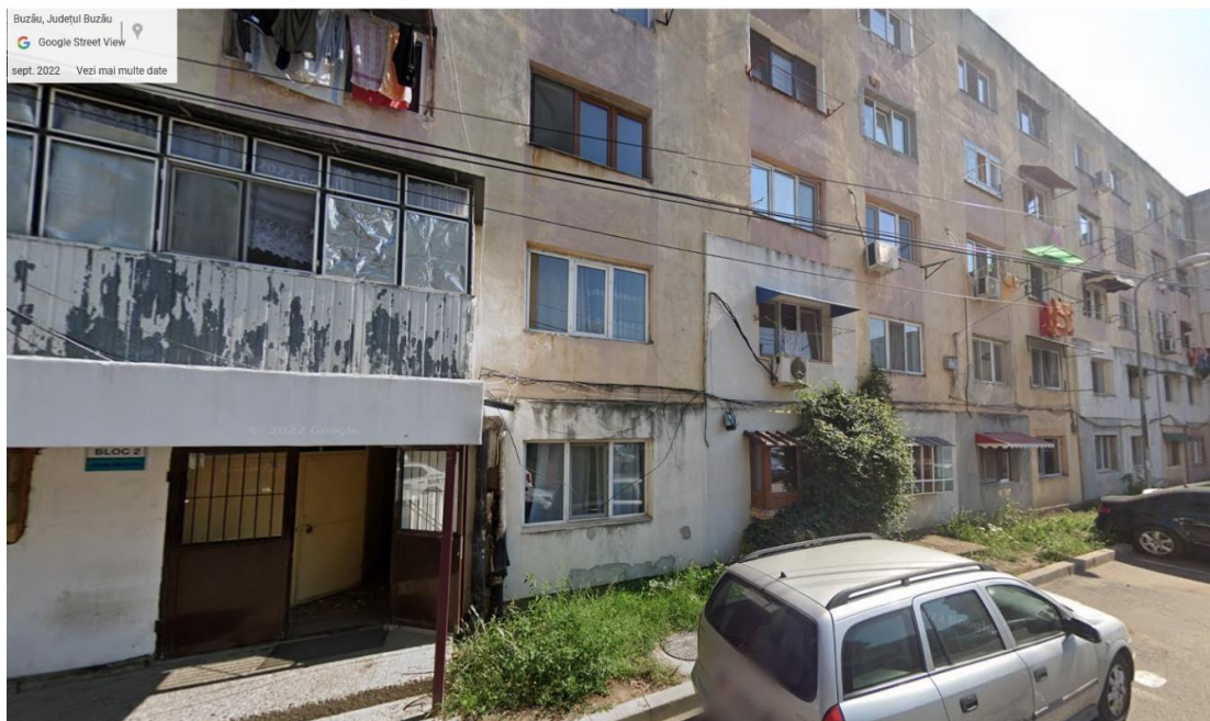
Figura 13 – Cămin 2 zona Contactoare Municipiul Buzău
