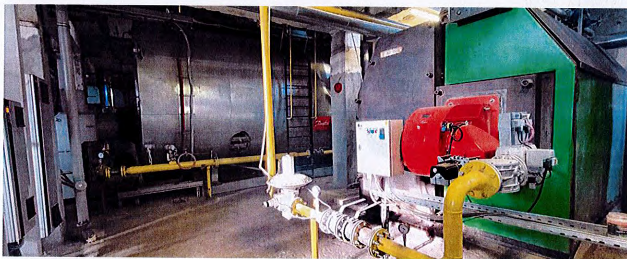
Fig. 6.e. CT 4 Dorobanți: cazan HR3-3200 (dreapta), respectiv cazan 10 Gcal CIAF 10x15-00 (stânga)
