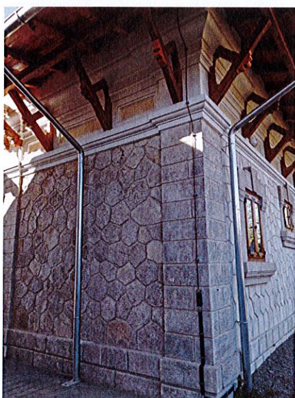
Detalii parament piatră fațade și elemente din lemn fasonat la cornișe
