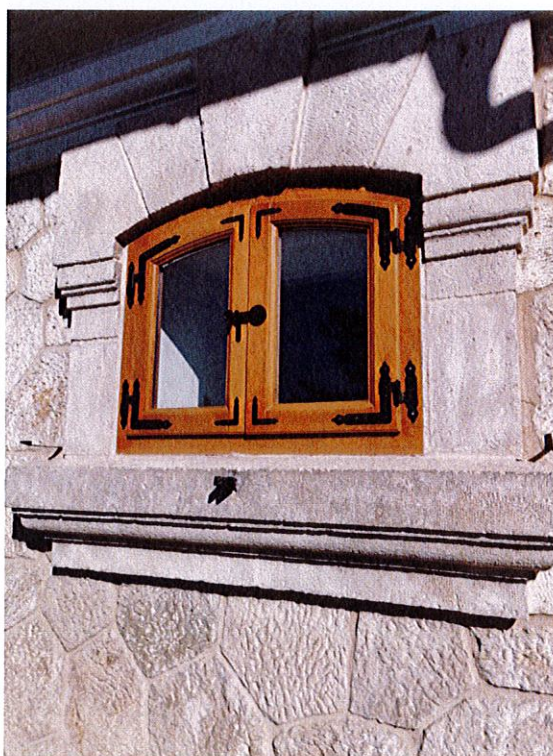
Detaliu tâmplărie și ancadrament din piatră
