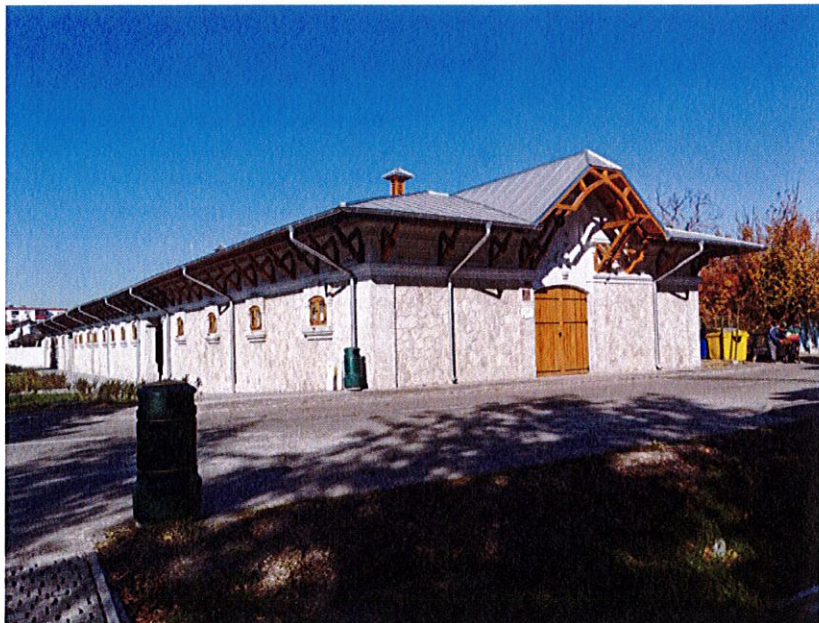
Imaginea Corpului A al clădirii Grajdurilor, din str. Plantelor.
