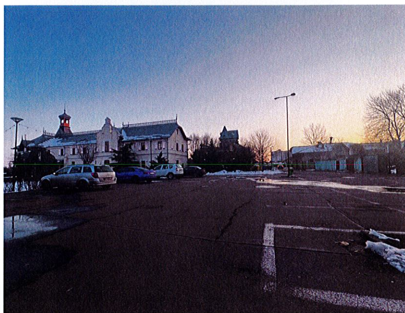
Imagine cu Vila Albatros și fațada NE a grajdurilor, din zona parcerii
