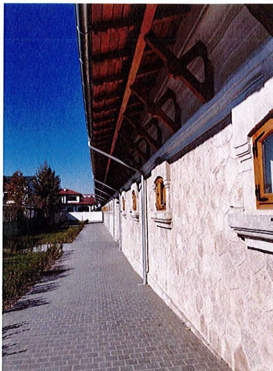
Fațada de SV
