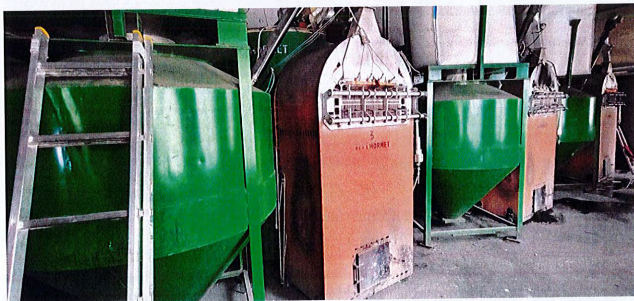
Fig. 6.17. Sub-contur 4: CT Integral, echipată cu 3 cazane ecoHORNCT CTP 350 (525 kW fiecare)
