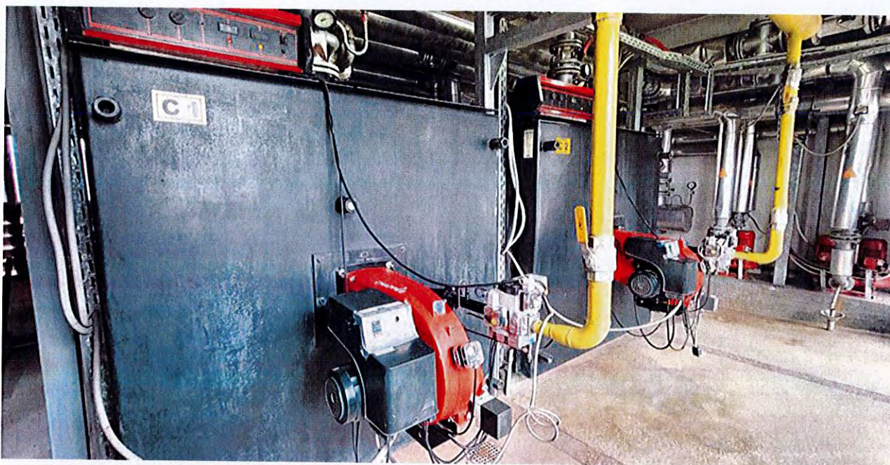
Fig. 6.d. CT5 Micro XIV cu 2 cazane Chappee Arizona 1400, echipate cu arzătoare SICMA GS151 RAG
